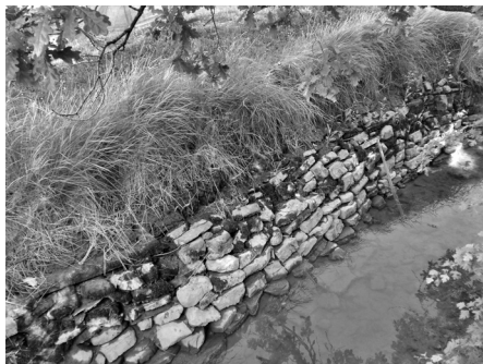
Restes d'un lezón o mur de contenció sobre un canal que baixa a la regata de Jaitzubia, a Hondarribia
